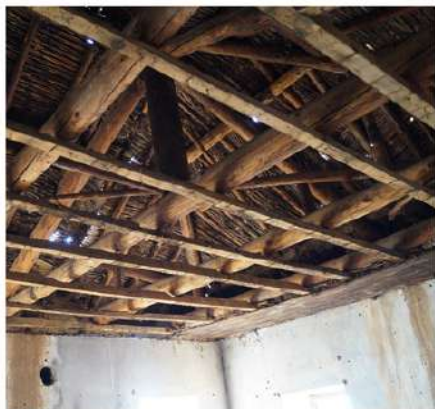
εσωτερική λεπτομέρεια ζευκτού
